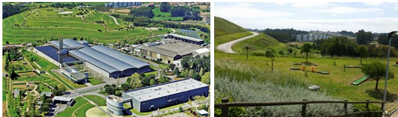
Figura 30 - As instalações da LIPOR, em Gondomar (fonte: Lipor ).
