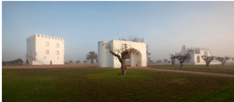
Figura 28 - Fotografia do património histórico localizado na Herdade do Esporão (fonte: Esporão S.A., 2017).
